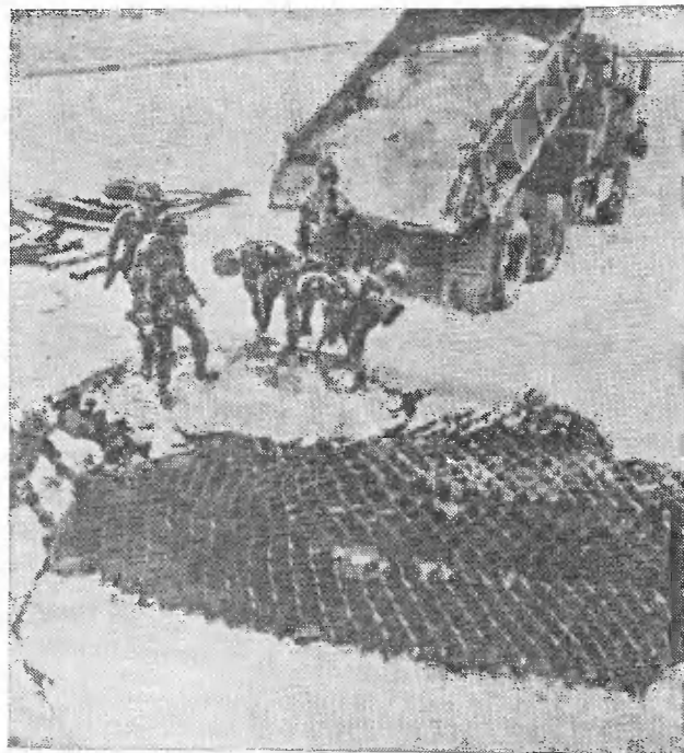
Рис. 1. Личный состав инженерного подразделения осуществляет укладку стабилизирующей сетки и наполнение ячеек грунтом
